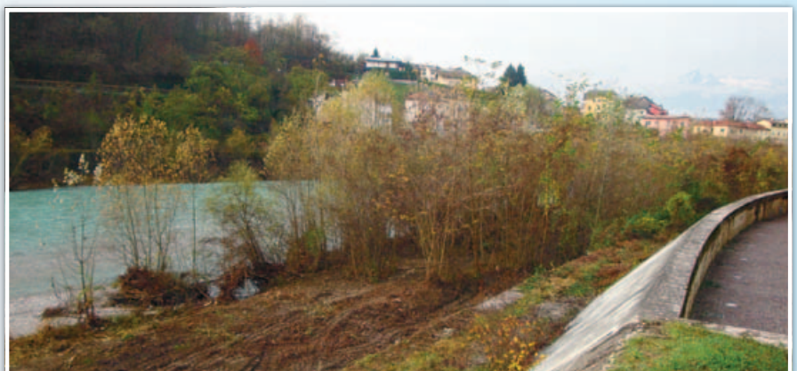
Argini del Piave. Si può vedere l'intervento di pulizia preventiva operato dal Comune.
